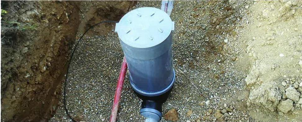
**1 / Canalisation e160 SN8 à Joint :** le matériau sera adapté (PVC, fonte, polypropylène ...) en fonction des contraintes propres au chantier, de la profondeur ou de la nature du sol.
